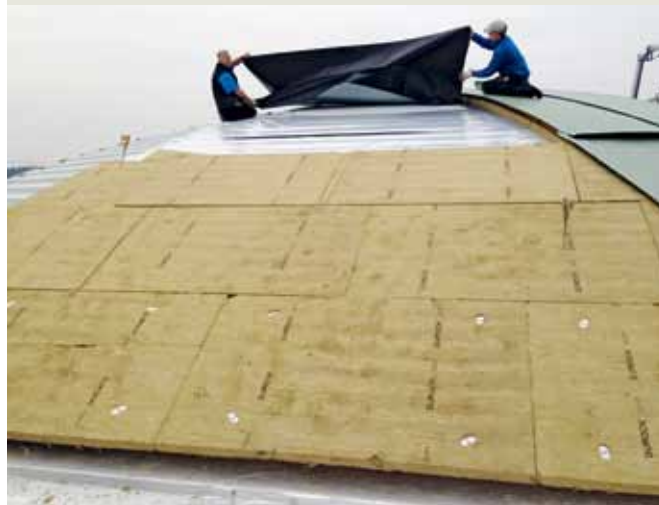
Auf die Stahltrapezdecker verlegten die Dachdecker eine selbstklebende, brandlastarme Dampfsperbahn.
