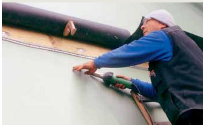
Anders als bei den Hauptdachflächen mit dem Automaten erfolgte die Verschweißung der Dachbahnen an der Kuppel aufgrund der Dachneigung mit einem Handschweißgerät.
