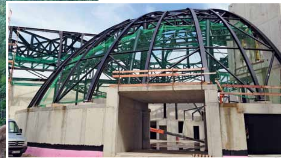
Ein Stahlgerüst dient als Tragkonstruktion für Halle und Kuppel.
