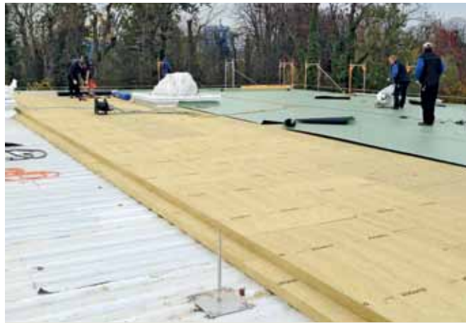
Die Flächen teilten sich in 3 Bereiche auf: Das 2.300 m 2 große Hauptdach erhielt auf der Stahltrapezkonstruktion einen mechanisch fixierten Warmdachaufbau mit einer FPO-Kunststoffdachbahn in der Farbe Resedagrün.
