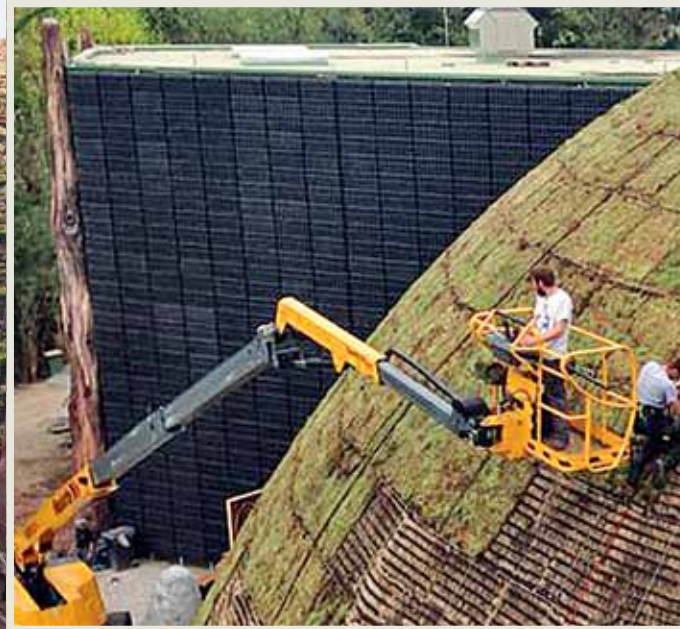
Vegetationsmatten bilden die Grundlage der Begrünung an Wand-, Dach- und Kuppelflächen. Mithilfe eines Hubsteigers und zusätzlichen Sicherungsseilen konnten die steilen Dachflächen erreicht werden.
