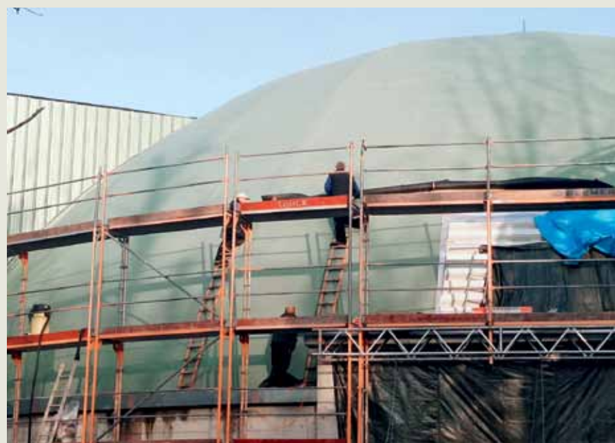
Letzte Arbeiten an der Hauptkuppel, bevor der Gründachaufbau verlegt wird
